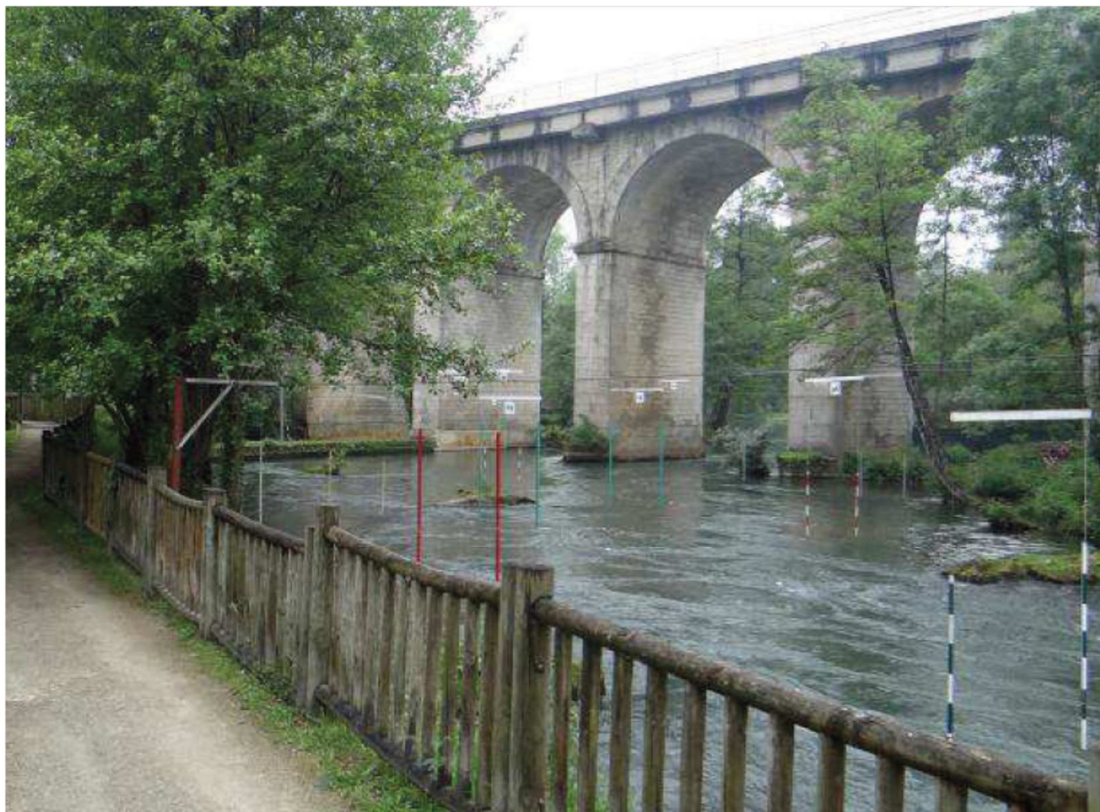
Le viaduc de Foulpougne s'impose dans le paysage depuis 1852. (photo Jacques Thibault)
