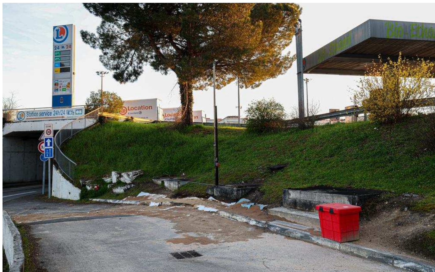
La station Leclerc a dû mettre en place des dispositifs absorbants sur le talus au niveau de l'aire de dépotage pour capter les hydrocarbures résiduels.
